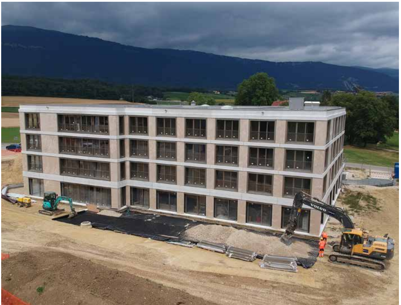
Chantier de l'EMS Montchoisi
